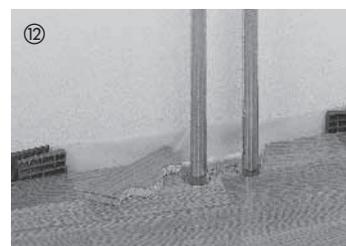
Découper et percer des ouvertures pour les tuyaux de chauffage sortant du sol (selon la taille des tuyaux et sans oublier le jeu de dilatation).
