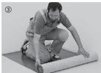
Pour l'isolation phonique et l'égalisation des petites aspérités, il convient de dérouler jusqu'aux bords une sous-couche acoustique confort de 2 mm d'épaisseur. D'autres sous-couches isolantes adaptées sont également disponibles parmi notre gamme d'accessoires. Le carton bitumé ne se prête pas à l'isolation phonique. **Tout parquet avec une sous-couche isolante contrecollée n'est pas compatible avec une pose collée en plein.**
