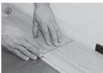
Следующие элементы первого ряда зашелкиваются сверху на торцах в предыдущую доску. После быстрого нажатия на поперечный стык элемент входит в зацепление со смежным элементом. При этом необходимо обращать внимание на точную соосность элементов. Последний элемент первого ряда должен быть отрезан так, чтобы между ним и стеной оставался расширительный шов 10-15 мм, и вставлен в смежный элемент.
