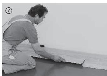
Оставшаяся часть первого ряда служит началом следующего ряда (смещение с торцевой стороны не менее 50 см). Благодаря этому существенно уменьшается количество отходов. Далее выполняется укладка отдельных элементов. Для этого элементы сначала вставляются продольной стороной с помощью легкого нажатия с поворотом в смежную доску.
