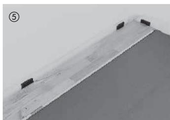
Начиная с правого угла комнаты, элементы укладываются гребнем к стене и фиксируются распорными клиньями или дистанционной прокладкой (расстояние до стены для компенсации расширения 10 - 15 мм).
