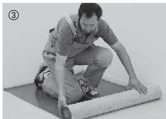
Для изоляции от ударного шума и для сглаживания небольших неровностей укладывается заподлицо изоляционная подкладка Komfort толщиной 2 мм. Подходящие изоляционные подкладки представлены в нашем ассортименте вспомогательных материалов. Битумный картон непригоден для изоляции ударного шума. **Паркет с наклеенной изоляционной подкладкой непригоден для сплошной наклейки.**
