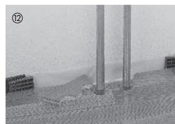
Для труб отопления, выступающих из пола, в элементах высверливаются или выпиливаются отверстия (размер отверстий зависит от соответствующей трубы отопления с учетом необходимого зазора на расширение).
