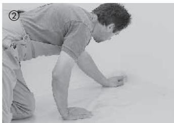
В случае бесшовных стяжек и при укладке на обогреваемый пол следует всегда подкладывать полиэтиленовую пленку толщиной 0,2 мм. В зоне стыков внахлест пленки должен составлять 30 см. Уложенную пленку следует подтянуть вверх возле стены и после монтажа плинтуса отрезать выступающий край.
