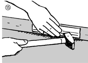
Nach der Verlegung unbedingt die Abstandskeile entfernen. Sockelleisten (mit und ohne Clip-System montierbar) werden an der Wand befestigt – fertig.
