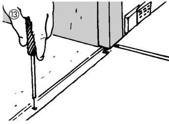
Zur Einhaltung des Dehnungsabstandes muss bei Türübergängen stets ein geeignetes Profilsystem eingesetzt werden. Dies gilt auch, wenn im angrenzenden Raum der gleiche Boden verlegt werden soll. In diesem Fall ist für die Einhaltung der Dehnungsfuge ein Übergangprofil einzusetzen. In der Schiene ist ein Dehnungsabstand von ca. 5 mm einzuhalten. Grundsätzlich müssen Holzürstösche in Parkettelementdicke mit einer Feinsäge abgeschnitten werden, damit das Parkett eine Dehnungsmöglichkeit hat.
