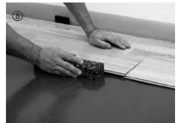
⑧ Se necessario, battere leggermente con l'apposito legno.
