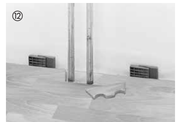
⑫ Per i tubi del riscaldamento che spuntano dal pavimento, eseguire delle aperture negli elementi con il trapano o la sega (dimensioni in relazione al tubo di riscaldamento in questione e tenendo conto della distanza di dilatazione necessaria).
