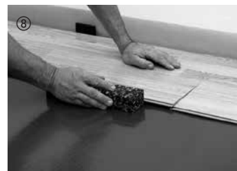
Si nécessaire, taper doucement avec la cale de frappe.
