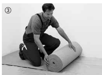
Pour l'isolation phonique et l'égalisation des petites aspérités, il convient de dérouler jusqu'aux bords un rouleau de liège de 2 mm d'épaisseur. D'autres sous-couches isolantes alternatives sont également disponibles parmi notre gamme d'accessoires. Le carton bitumé ne se prête pas à l'isolation phonique. Pour le revêtement de sol stratifié avec sous-couche isolante contrecollée, ne pas poser de sous-couche isolante supplémentaire.
