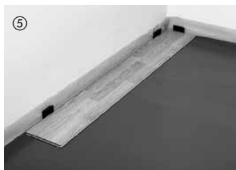
Pour commencer, poser les premières lames au coin droit de la pièce avec la languette côté mur et fixer à l'aide de cales biseautées (respecter un jeu de dilatation de 10 à 15 mm par rapport au mur).
