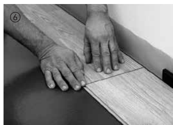
Les autres lames de la première rangée doivent être encliquetées par le haut au niveau des extrémités dans la lame précédente. En appuyant légèrement sur le chant transversal, la lame s'enclenche dans la lame voisine. Veillez à respecter un alignement exact des lames. La dernière lame de la première rangée est coupée en respectant le jeu de dilatation de 10 à 15 mm par rapport au mur et emboîtée.
