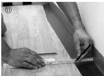
Couper les grands côtés des éléments de la dernière rangée en tenant compte du jeu de dilatation de 10 à 15 mm et les emboîter.
