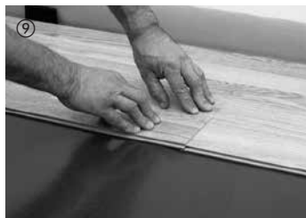
La lame est abaissée à l'about. Veillez à cet égard que la lame soit glissée sur l'about aux abords de l'arête de la lame posée précédemment. En appuyant légèrement sur le chant transversal, la lame s'enclenche.
