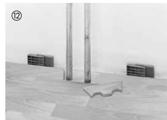
Découper ou percer des ouvertures pour les tuyaux de chauffage sortant du sol (selon la taille des tuyaux et sans oublier le jeu de dilatation).
