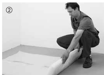
En règle générale, il faut toujours poser un film en polyéthylène de 0,2 mm d'épaisseur sur toutes les chapes et lors d'une pose sur un chauffage au sol. Les raccords des couches de film doivent se chevaucher sur environ 30 cm. Relever le film sur le mur et le couper après le montage des plinthes sur l'arête supérieure de ces dernières.
