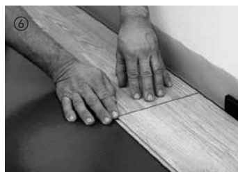
⑥ De øvrige elementer i første række skal klikkes ind oppefra i det forrige bræt ved hovedenderne. Ved et kort tryk på tværsamlingen klikker elementet ind i det tilstødende element. Vær opmærksom på, at elementerne flugter nøjagtigt. Det sidste element i første række tilskæres og indsættes, idet der tages højde for en ekspansionsafstand på 10 – 15 mm til væggen.
