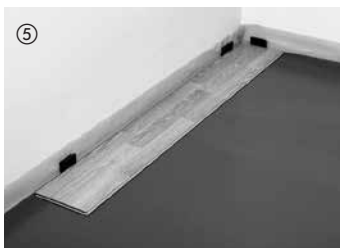
⑤ Lægningen startes i højre hjørne af rummet. Elementerne lægges med federsiden mod væggen og fikseres med afstandskiler (ekspansionsafstand til væg 10–15 mm).
