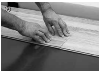
9 Anschließend wird das Element stirnseitig abgesenkt. Beachten Sie hierbei, dass das Element stirnseitig bündig an das zuvor verlegte Element anstößt. Durch kurzen Druck auf den Querstoß rastet das Element ein.
