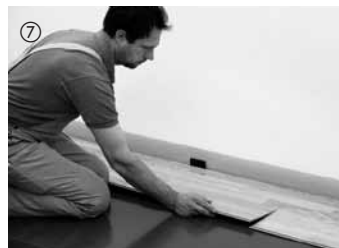
7 Mit dem Reststück der ersten Reihe wird in der nächsten Reihe wieder begonnen (stirnseitiger Versatz von mindestens 50 cm). Dadurch wird der Verschnitt erheblich reduziert. Die weitere Verlegung erfolgt elementweise. Dazu werden die Elemente zuerst längsseitig mit leichtem Druck in die Verbindung eingedreht.
