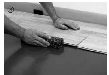
8 Bei Bedarf mit Schlagklotz leicht nachklopfen.
