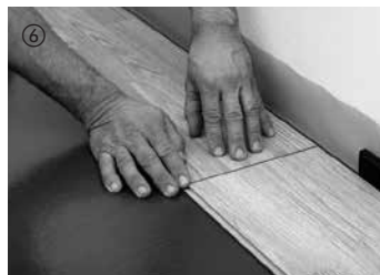
6 Die weiteren Elemente der ersten Reihe sind an den Kopfenden von oben in die vorherige Diele einzuklicken. Durch kurzen Druck auf den Querstoß rastet das Element im angrenzenden Element ein. Hierbei ist auf eine exakte Flucht der Elemente zu achten. Das letzte Element der ersten Reihe wird unter Berücksichtigung des Dehnungsabstandes von 10 – 15 mm zur Wand zugeschnitten und eingefügt.
