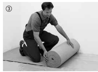
3 Zur Trittschalldämmung und zum Ausgleich kleiner Unebenheiten wird eine 2 mm dicke Korkdämmunterlage bündig ausgerollt. Alternative Dämmunterlagen finden Sie in unserem Zubehörangebot. Bitumpappe eignet sich nicht zur Trittschalldämmung. Bei Laminatboden mit aufkaschierter Dämmunterlage darf keine zusätzliche Dämmunterlage ausgelegt werden.
