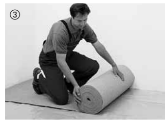
3 Zur Trittschalldämmung und zum Ausgleich kleiner Unebenheiten wird eine 2 mm dicke Korkdämmunterlage bündig ausgerollt. Alternative Dämmunterlagen finden Sie in unserem Zubehörangebot. Bitumenpappe eignet sich nicht zur Trittschalldämmung. Bei Laminatboden mit aufkaschierter Dämmunterlage darf keine zusätzliche Dämmunterlage ausgelegt werden.
