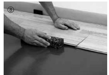
8 Bei Bedarf mit Schlagklotz leicht nachklopfen.
