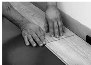
6 Die weiteren Elemente der ersten Reihe sind an den Kopfenden von oben in die vorherige Diele einzuklicken. Durch kurzen Druck auf den Querstoß rastet das Element im angrenzenden Element ein. Hierbei ist auf eine exakte Flucht der Elemente zu achten. Das letzte Element der ersten Reihe wird unter Berücksichtigung des Dehnungsabstandes von 10–15 mm zur Wand zugeschnitten und eingefügt.
