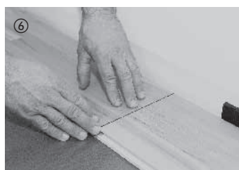
6 Kolejne elementy pierwszego rzędu należy od strony górnej w kierunku z góry wcisnąć do poprzedniej deski, aż do zablokowania. Po krótkim przyciśnięciu złącza poprzecznego element wskakuje w sąsiadujący element. Bardzo ważne jest przy tym dokładne wyrównanie elementów. Ostatni element pierwszego rzędu przycina się z uwzględnieniem szczeliny dylatacyjnej 10–15 mm od ściany i montuje.
