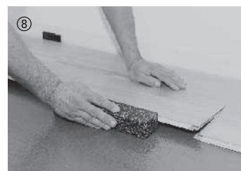
8 W razie potrzeby należy pod koniec lekko przybić warstwę przy użyciu kłocka.
