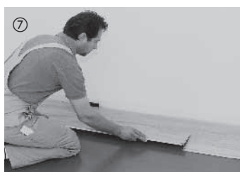
7 Końcówką pierwszego rzędu należy rozpocząć następny rząd (przesunięcie czołowe wynoszące przynajmniej 50 cm). Dzięki temu znacznie redukuje się straty materiału. Dalsze układanie odbywa się elementami. Najpierw elementy zostają połączone wzdłużnie, należy przy tym lekko je docisnąć.
