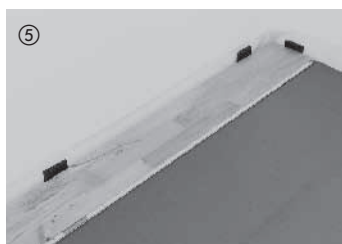
5 Zaczynając od prawego rogu pomieszczenia elementy układa się stroną pióra zwróconą do ściany oraz mocując za pomocą klinów dystansowych lub rozpórek (odstęp dylatacyjny od ściany 10 – 15 mm).
