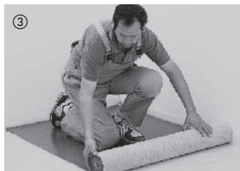
3 W celu wytlumienia odgłosu kroków oraz do wyrównania niewielkich nierówności rozkłada się podkład izolacyjny o grubości 2 m. Odpowiednie podkłady izolacyjne można znaleźć w naszej ofercie z akcesoriami. Papa bitumiczna nie nadaje się do tłumienia odgłosów stąpania. Parkiet z laminowanym podkładem tłumiącym nie nadaje się do przyklejania na całej powierzchni.
