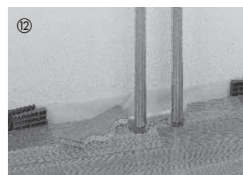
12 Dla rur wystających z podłogi należy wywiercić lub wyciąć otwory w elementach (wielkość zależy od przekroju danej rury; uwzględniając szczelinę dylatacyjną).
