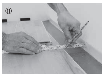
11 Elementy ostatniego rzędu przyciąć i dopasować po stronie wzdłużnej z uwzględnieniem szczeliny dylatacyjnej 10-15 mm.
