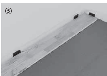
⑤ Lægningen skal starte i højre hjørne af rummet og fer – siden skal pejle mod muren, elementerne fikseres med afstandskiler eller PVA - afstandsholdere (afstanden til væggen skal være 10 – 15 mm.)
