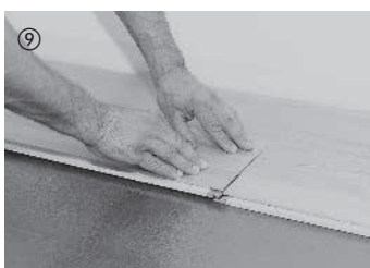
⑨ Derefter lægges elementet med enden først. Vær opmærksom på, at elementet støder helt op mod det tidligere lagte element i enden. Ved et kort tryk på tværsamlingen klikker elementet ind.
