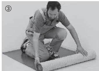
③ Til lyd-dæmpning og til udligning af små ujævnheder lægges et 2 mm tykt komfortunderlag Silent. Se også andre isoleringsmaterialer i vort tilbehørstilbud. Asfaltpap er ikke egnet til trinlydsisolering. Parket med pålimet isoleringsunderlag er ikke egnet til limning over hele fladen.
