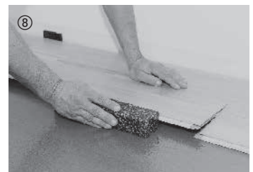
Bei Bedarf mit Schlagklotz leicht nachklopfen.
