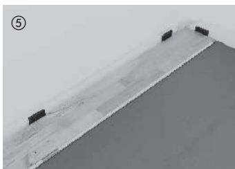
In der rechten Raumecke beginnend, werden die Elemente mit der Federseite zur Wand verlegt und mit Abstandskeilen oder Abstandhaltern fixiert (Dehnungsabstand zur Wand 10 – 15 mm).
