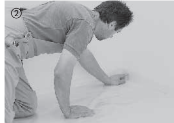
Grundsätzlich ist bei Estrichen und bei Verlegung auf Fußbodenheizung eine 0,2 mm starke PE-Folie auszulegen. Diese soll im Stoßbereich 30 cm überlappen. Anschließend die Folie im Wandbereich hochziehen und nach der Sockelleistenmontage an der Oberkante abtrennen.
