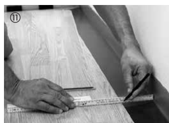
Die Elemente der letzten Reihe werden an der Längsseite unter Berücksichtigung eines Dehnungsabstandes von 10–15 mm zugeschnitten und eingepasst.
