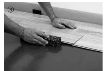
Bei Bedarf mit Schlagklotz leicht nachklopfen.
