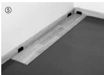
In der rechten Raumecke beginnend, werden die Elemente mit der Federseite zur Wand verlegt und mit Abstandskeilen fixiert (Dehnungsabstand zur Wand 10–15 mm).
