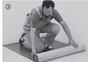
Zur Trittschalldämmung und zum Ausgleich kleiner Unebenheiten wird eine 2 mm dicke Komfort-Dämmunterlage bündig ausgerollt. Geeignete Dämmunterlagen finden Sie in unserem Zubehörangebot. Bitumenpappe eignet sich nicht zur Trittschalldämmung. Holzboden mit aufkaschierter Dämmunterlage ist für eine vollflächige Verklebung nicht geeignet.
