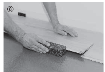
Bei Bedarf mit Schlagklotz leicht nachklopfen.
