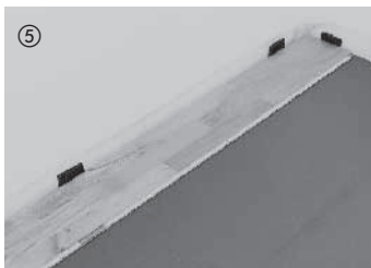
In der rechten Raumecke beginnend, werden die Elemente mit der Federseite zur Wand verlegt und mit Abstandskeilen oder Abstandhaltern fixiert (Dehnungsabstand zur Wand 10 – 15 mm).
