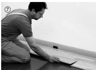
⑦ Start med resten af det afskårne stykke fra første række i den næste række (enderne skal forskydes min. 50 cm). Derved reduceres spildet meget. Lægningen fortsættes element for element. Først drejes elementerne på langs ind i samlingen med et let tryk.
