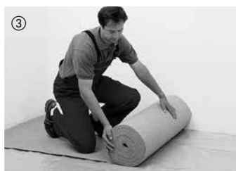
③ Til trinlydisolering og til udligning af mindre ujævnheder udrulles et 2 mm tykt isoleringslag af kork uden buler. Se også andre isoleringsmaterialer i vort tilbehørstilbud. Asfaltpap er ikke egnet til trinlydisolering. Ved HARO laminatgulv med Silent Pro ® må der ikke anvendes yderligere isolering.
