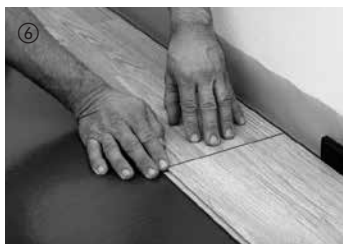
⑥ De øvrige elementer i første række skal klikkes ind oppefra i det forrige bræt ved hovedenderne. Ved et kort tryk på tværsamlingen klikker elementet ind i det tilstødende element. Vær opmærksom på, at elementerne flugter nøjagtigt. Det sidste element i første række tilskæres og indsættes, idet der tages højde for en ekspansionsafstand på 10 – 15 mm til væggen.
