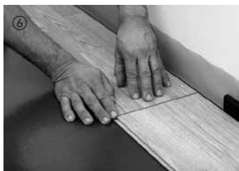
⑥ Další prvky první řady se na koncích zaklapnou shora do předcházejícího prkna. Krátkým tlakem na příčnou spáru se prvek zaklapne do přilehlého prvku. Přitom je třeba dbát na přesné sladění prvků. Poslední prvek první řady se přířízne a zasune, přičemž je nutné zohlednit dilatační vzdálenost ke stěně 10–15 mm.
