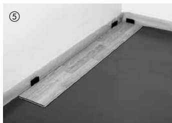
⑤ Začnete v pravém rohu místnosti. Prvky pokládejte stranou s perem ke stěně a zafixujte distančními klíny nebo rozpěrkami (distanční odstup od stěny 10–15 mm).
