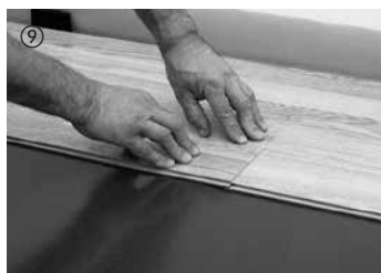
⑨ Následně se prvek čelně usadí. Dávejte přitom pozor, aby prvek čelně spojitě navazoval na předcházející položený prvek. Krátkým tlakem na příčnou spáru se prvek zaklapne.
