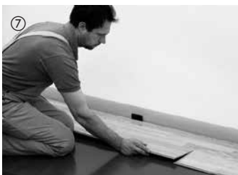
⑦ Se zbývajícím kusem první řady se znovu začne v další řadě (odsazení z čelní strany minimálně 50 cm). Tím se podstatně sníží prořez. Další pokládka probíhá pokládáním po prvcích. K tomu je nutné palubky nejdříve lehkým tlakem zasunout podélnou stranou do spoje.
