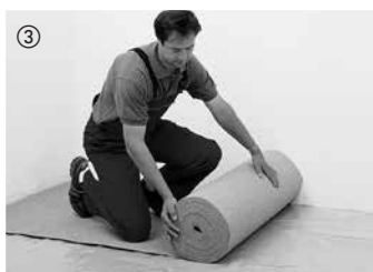
③ Pro vytvoření izolace kročejových zvuků a pro vyrovnání drobných nerovností se rozvine a těsně položí 2 mm silná korková izolační podložka. Alternativní izolační podložky jsou součástí naší nabídky příslušenství. Bitumenová lepenka není vhodná jako izolace proti kročejovému hluku. U laminátových podlah HARO Silent Pro® se nesmí pokládat žádná další izolační podložka.
