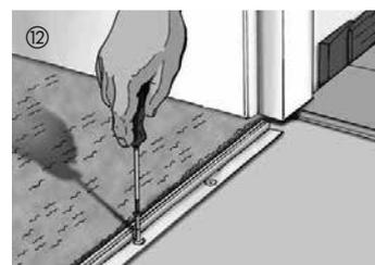
Per rispettare la distanza di dilatazione, inserire sempre un sistema di profili adeguato nei passaggi delle porte. Questo vale anche se nell'area adiacente deve essere posato lo stesso pavimento. In questo caso, per mantenere il giunto di dilatazione occorre impiegare un profilo di giunzione.
