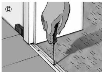
Nella guida mantenere una distanza di dilatazione di circa 5 mm. In linea di massima, si devono tagliare con una sega fine i piani delle porte in legno nello spessore degli elementi, per far sì che DISANO Life abbia la possibilità di dilatarsi. Dopo la posa togliere assolutamente i cunei distanziali. Fissare alla parete i battiscopa (montabili con o senza il sistema a clip) – ed ecco fatto.
