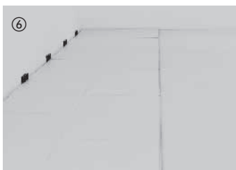
⑥ Inden du lægger de øvrige rækker, er det absolut vigtigt at kontrollere at de to første rækker flugter nøjagtigt. Når rækkerne er rettet korrekt ind, skal de fastgøres i kanten med afstandskiler. Efter behov kan du banke let efter på langsiden.
