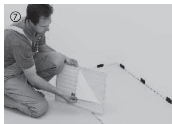
⑦ På det første element i den tredje række skal den beskyttende klæbefolie fjernes, inden elementet lægges. Folien bør trækkes af i let skrå retning, så man undgår at den river elementet i stykker. Du kan nu dreje elementet med kunststoffederen ind i de to første rækker med langsiden og sænke det. Start i venstre side. Fjern ligeledes klæbefolien fra det næste element og drej det på plads.
