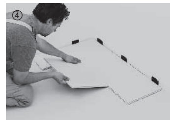
④ Begynd med de to første rækker i venstre side; tag højde for at endefladerne skal forskydes med min. 18 cm. De skal lægges samtidigt i stigemønster. Drej elementerne i første række ind i det allerede lagte element med endefladerne først. Drej elementerne i anden række ind i de allerede lagte elementer i første række på langs og sænk dem. Ved lægning af de første to rækker må den beskyttende klæbefolie på bagsiden af brædderne ikke fjernes.
