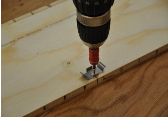
16. Fixation des agrafes de fin
