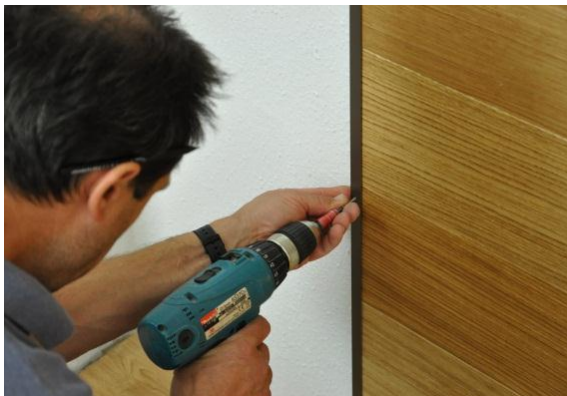
18. Pose du cadre en aluminium
