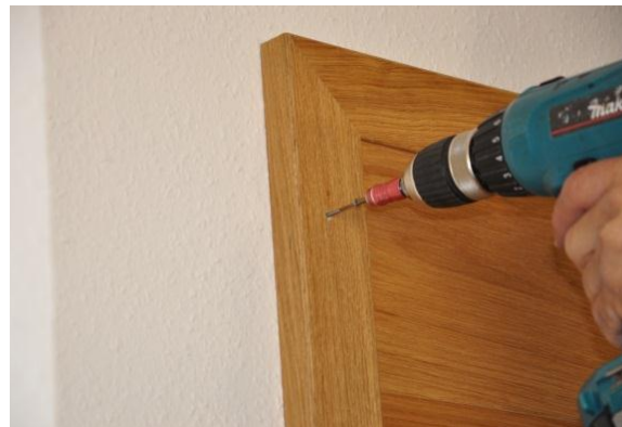
19. Pose du cadre en parquet
