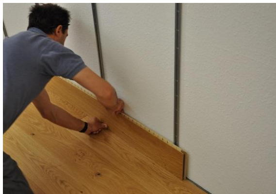
7. Une fois les agrafes de début posées, les planches s'encliquètent simplement dans les rails de fixation.
