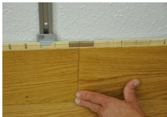
8. Montez la première rangée de gauche à droite et verrouillez chaque élément au niveau de l'about.
