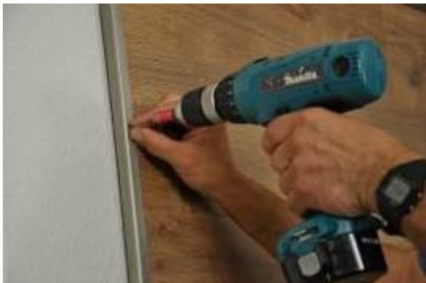
18. Anbringung des Abdeckprofils Alu
