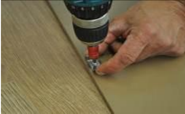
16. Anbringung der Endklammern
