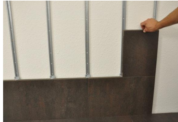
13. La deuxième rangée peut être commencée avec le reste de la première rangée (décalage des joints en bout d'élément d'une demi-longueur). Le montage s'effectue toujours de droite à gauche.
