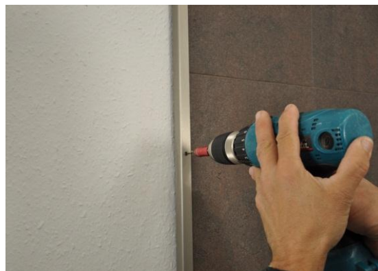
18. Fixez les baguettes de protection HARO adéquates pour recouvrir les côtés des éléments muraux.
